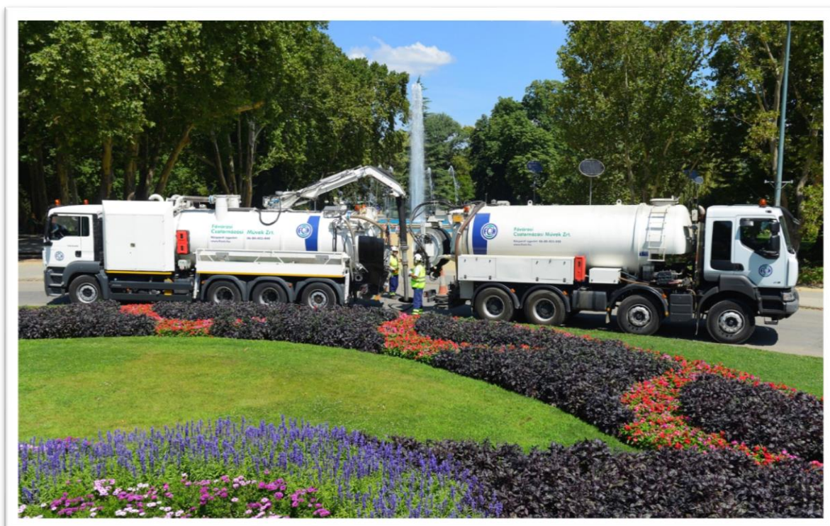
4. ábra: csatornatisztítási művelet egy szívó és egy mosó kocsival (Forrás: belső vállalati adatok alapján)
