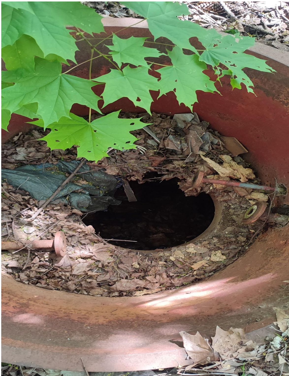
7. ábra: Üzemanyag tároló akna.
