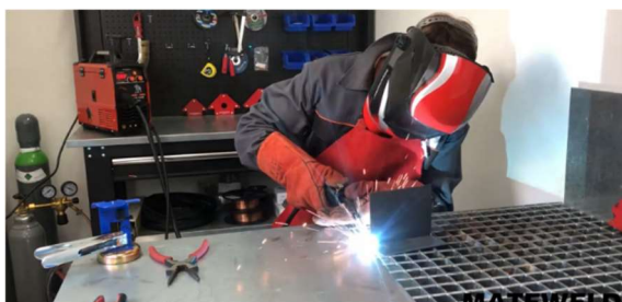
41. ábra: Fogyóelektródás védőgázos ívhegesztés (Forrás: MATEWELD Hungary)
