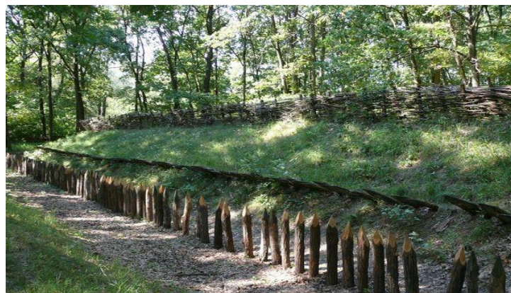
9. kép: Rekonstruált Csörsz-árok részlet Fót környékén
