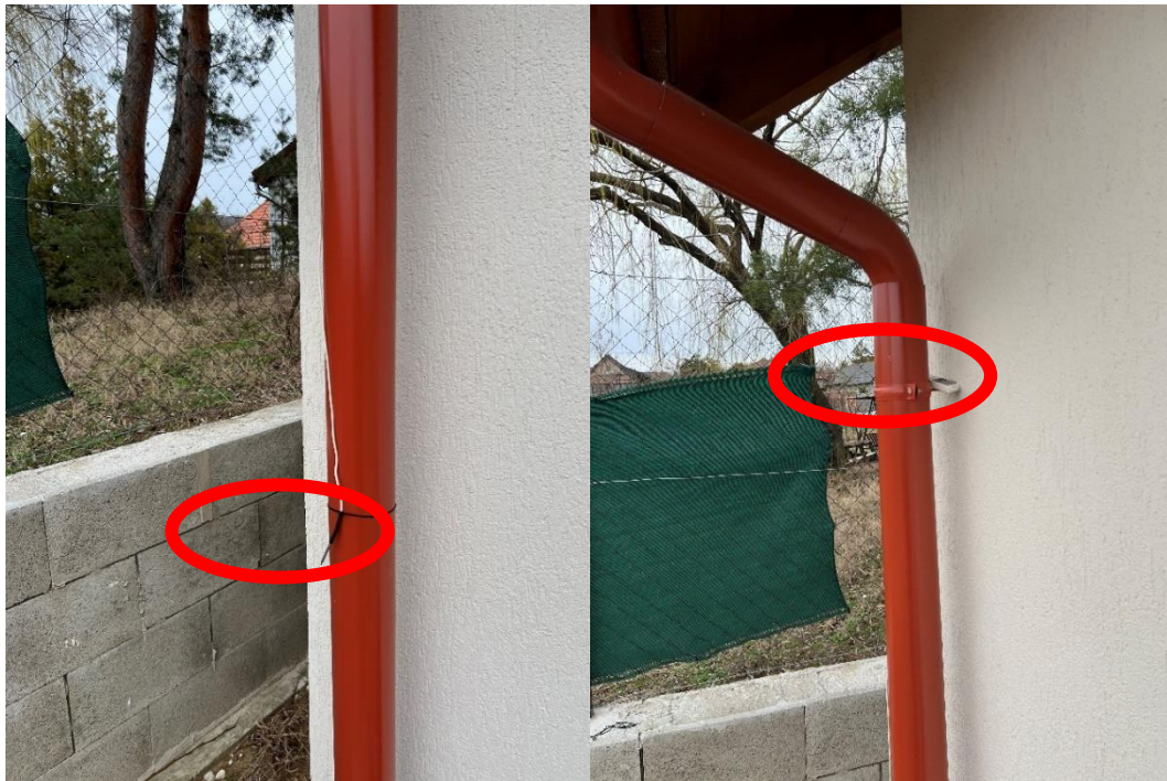
20. ábra: Környezeti hőmérséklet érzékelő elhelyezése (forrás: saját kép)
