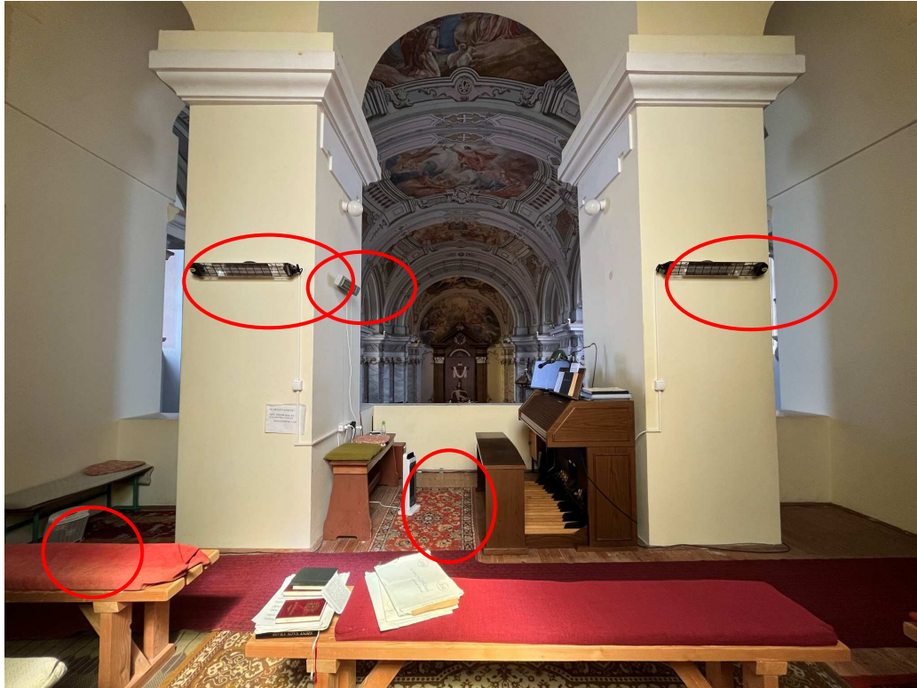
40. ábra – Nyergesújfalui Szent Mihály templom kórus fűtőberendezései (Forrás: saját felvétel, 2023)
