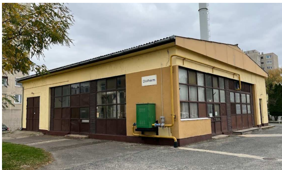
41. ábra – Nyergesújfalu, DISTHERM Kft. kazánház
