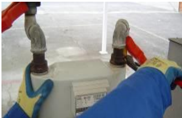
5. ábra Gázmérő felhelyezése (MVM Főgáz Földgázhálózati Kft. G-TU-04, 2022)
