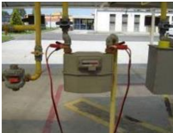
3. ábra Potenciálátkötő felhelyezése (MVM Főgáz Földgázhálózati Kft. G-TU-04, 2022)
