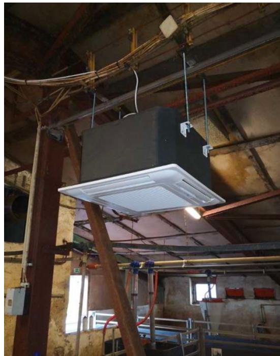
5. ábra: A kísérleti istállóban felszerelt légtisztító berendezés Fotó: Márton Ferenc, 2023
