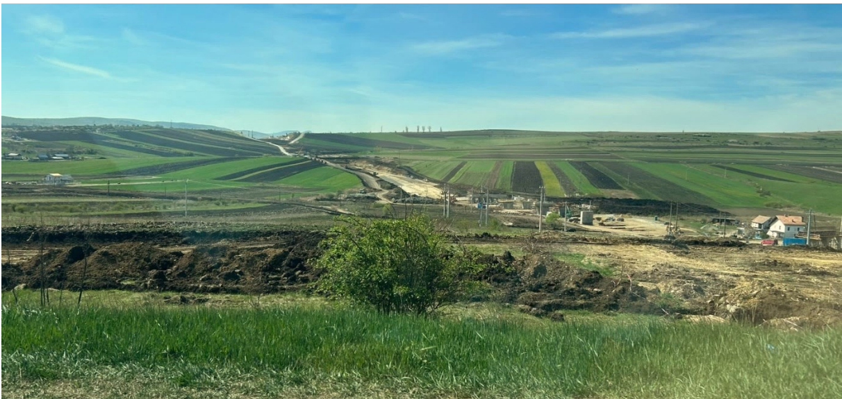
9. ábra: Az A3-as autópálya leszálló gyorsforgalmi útjának építése Tordatúrnál 2024
