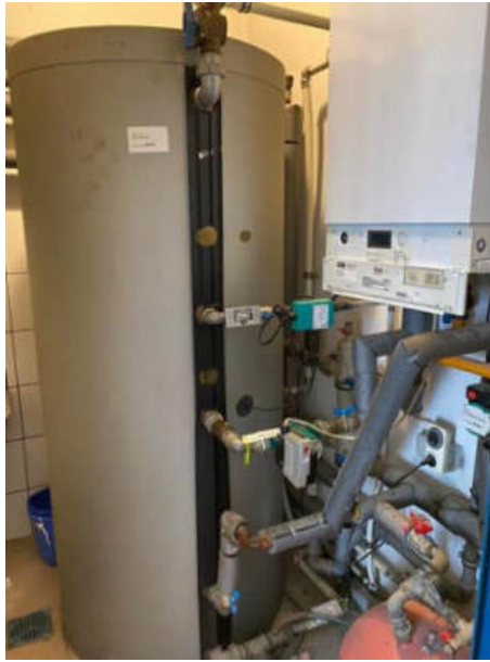
8. kép: Karbantartó épület (0,5 m 3 HMV)
