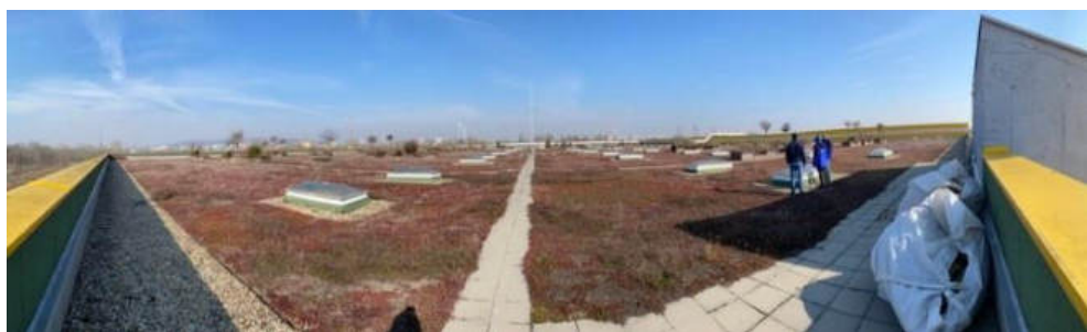
15. kép: Utóülepítő tető panoráma
