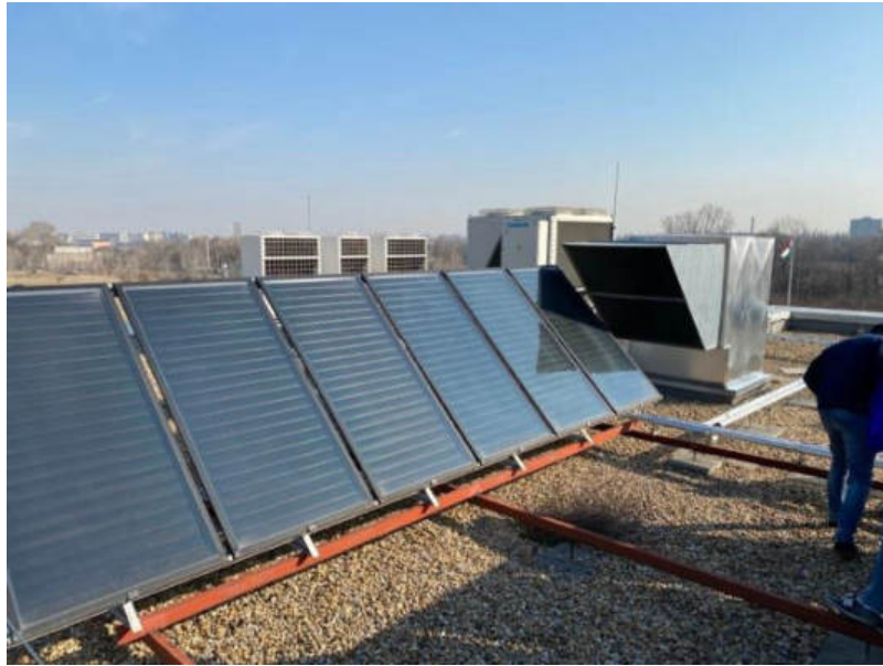
11. kép: Főépület (2x6 db Napkollektor)
