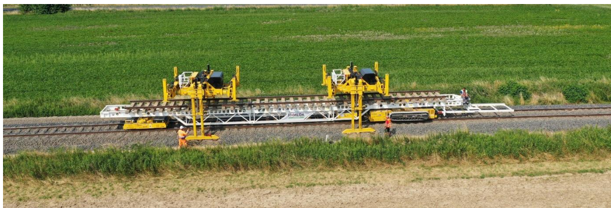
2.2. ábra Vágány és kitérő fektető gépcsoport {2}
