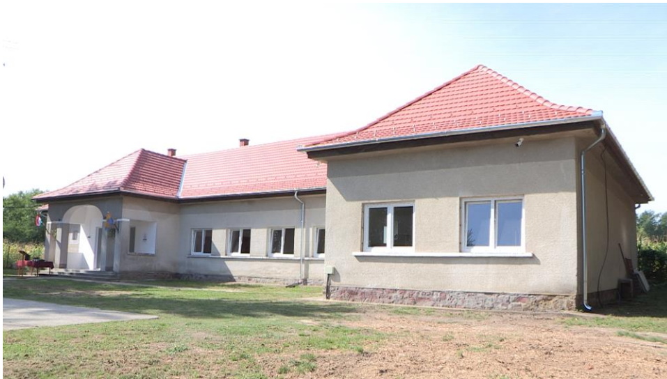
36.ábra: Művelődési ház épülete
