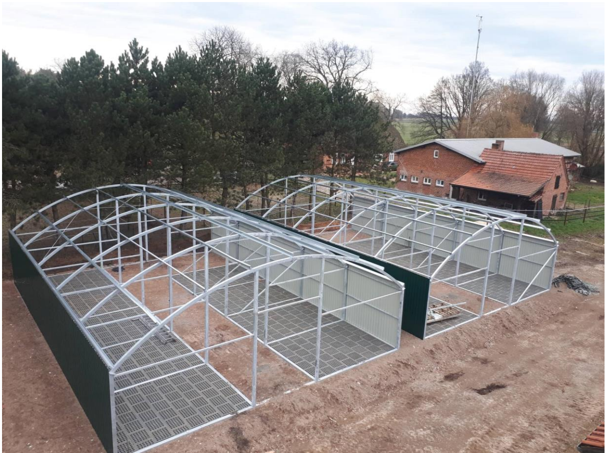
15.ábra Bokszos donga csarnok acélszerkezete
