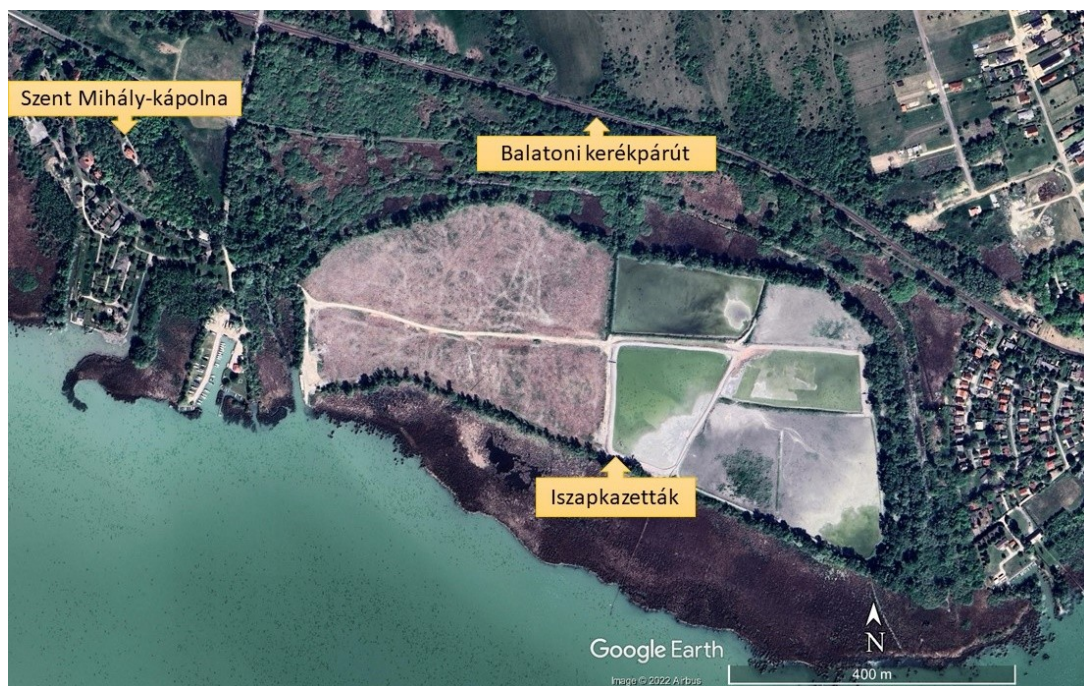
17. ábra: Iszapkazetták elhelyezkedése Balatongyörökön (Forrás: Google Earth)
