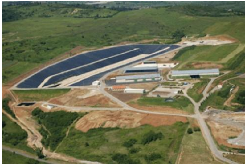
4. ábra Sajókazai Hulladékkezelő Centrum (Forrás: sajobodvaszelektiv.hu)
