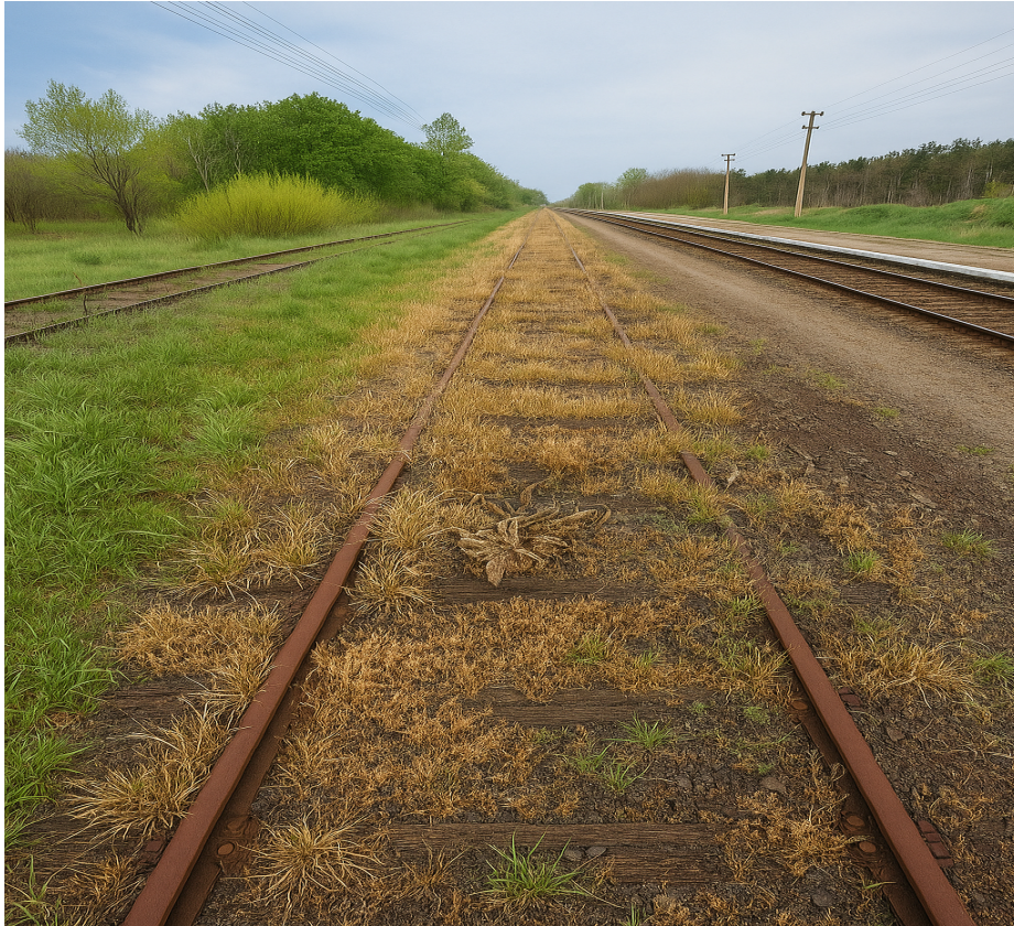
15. ábra Gyomosodási kép a vágányok között kezelés után 2 héttel, Lados K., Nyárlőrinc, 2025.04.17.
