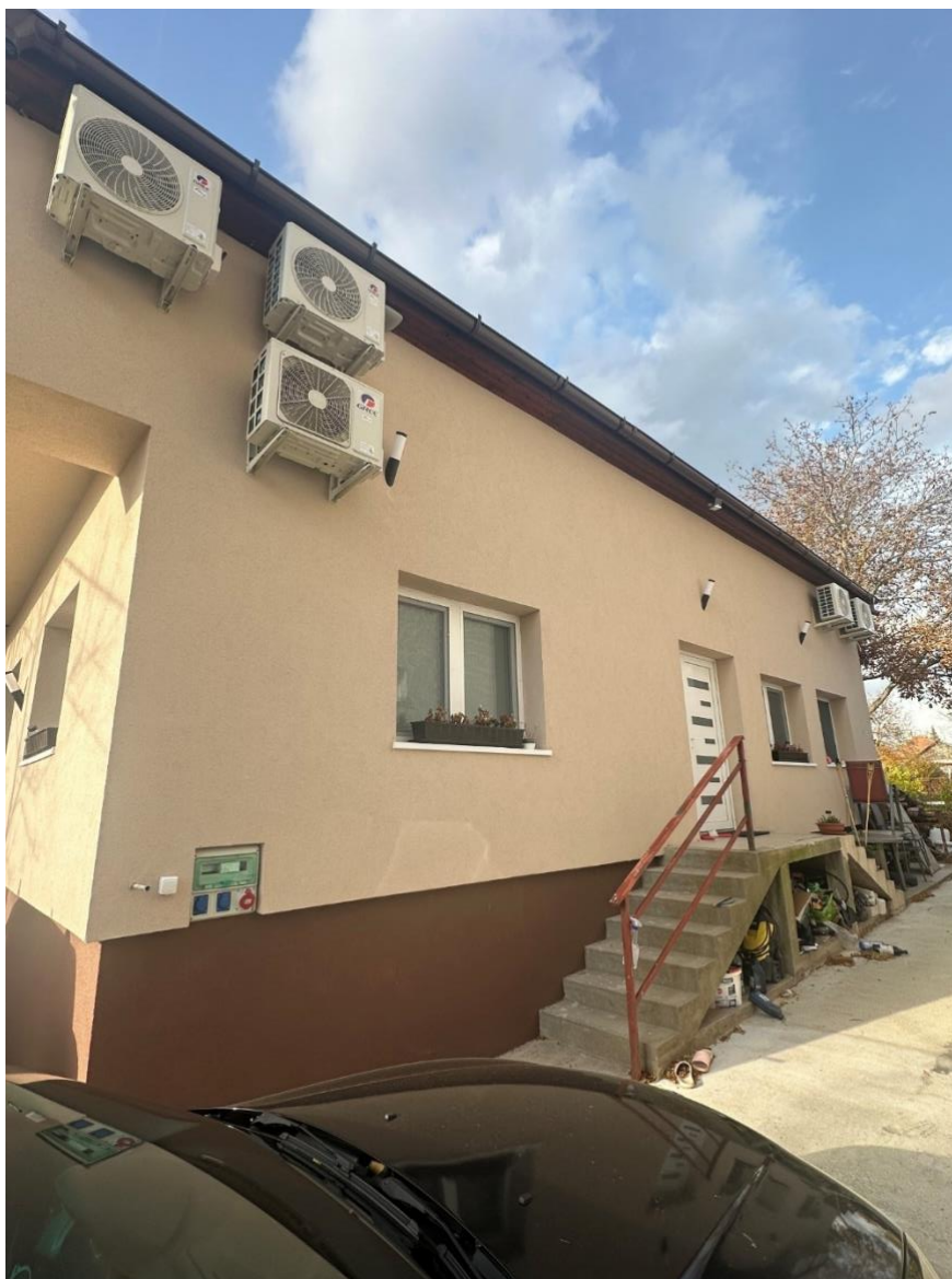
26. ábra: megvalósult split klímák telepítése
