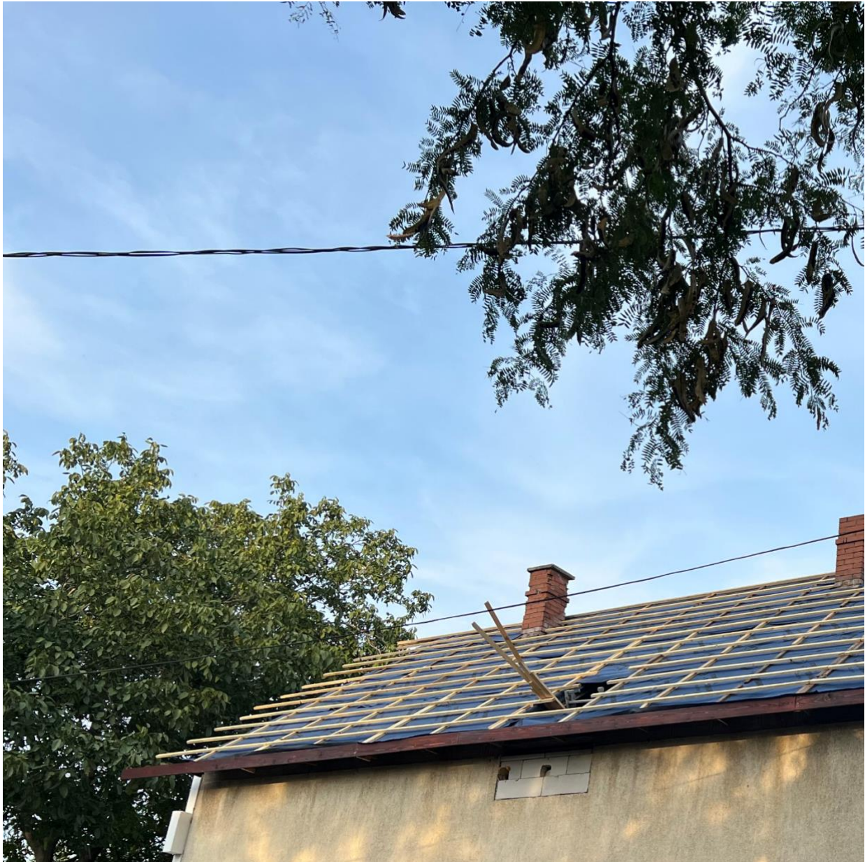
21. ábra: megvalósult födém szigetelés és héjazat csere
