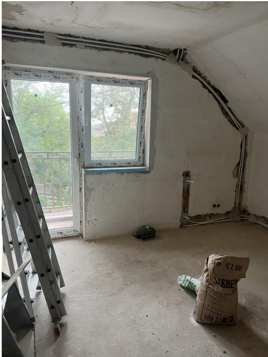
25. ábra: megvalósult fűtési csővezeték csere
