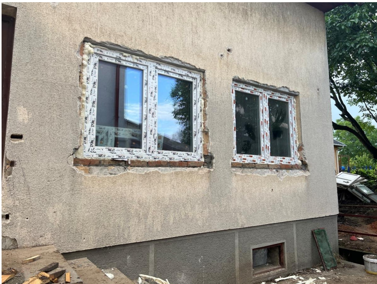
22. ábra: megvalósult nyílászáró csere
