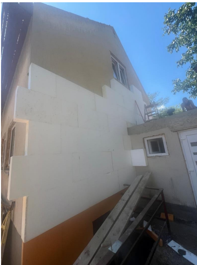
21. ábra: megvalósult külső fal szigetelés
