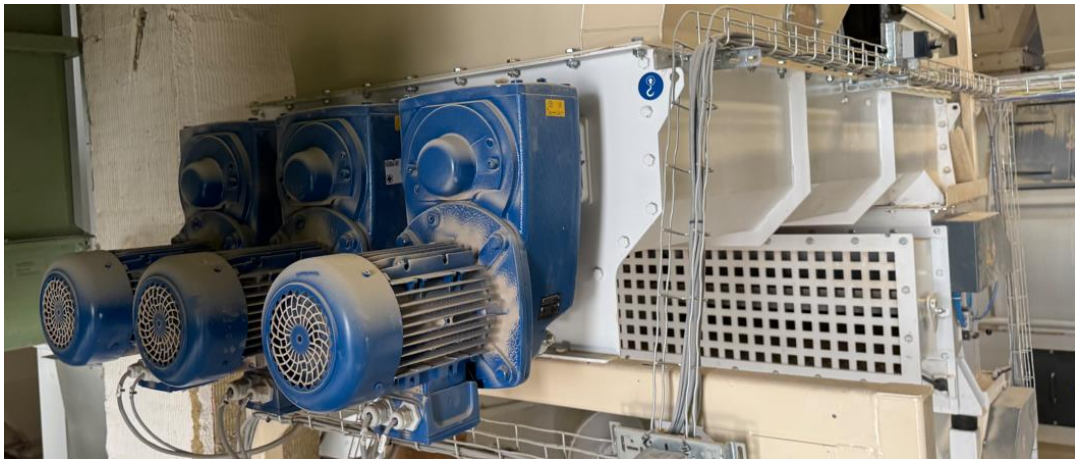
5.ábra: Kalapácsos daráló adagoló csigák és hajtómotorjai
