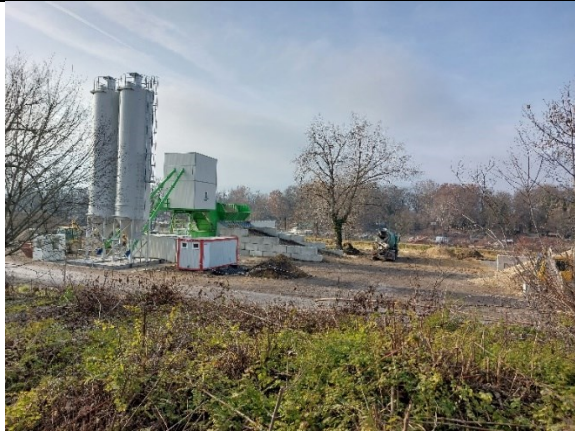
58. ábra Jelenlegi állapot a Meder utcánál (forrás: saját kép)
