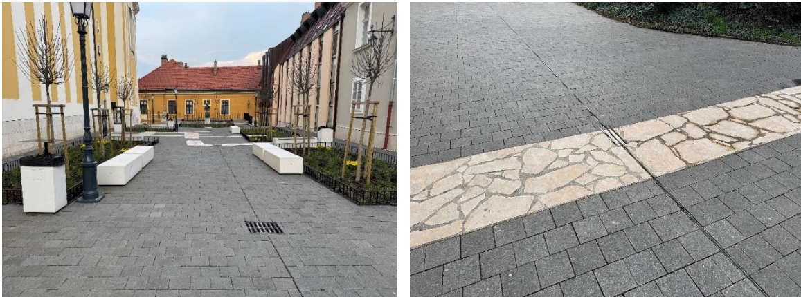
34-35. ábra: A Géza nagyfejedelem tér burkolata, valamint a burkolatba illesztett mészkő intarzia.
