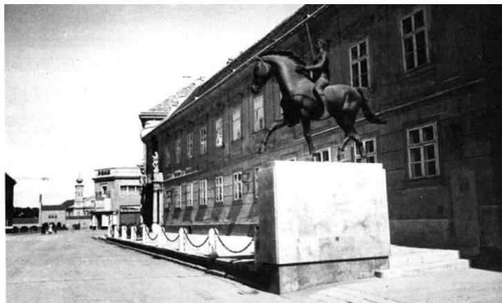
9. ábra: A Városház tér az 1938-as ünnepi év felújításait követően.
