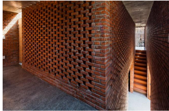
21. kép Téglaburkolat 4. (forrás: Oki Hiroyuki)
