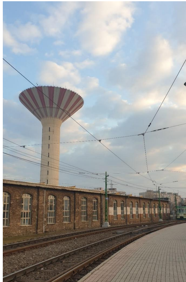
15. kép Csepel víztorony (saját fotó)
