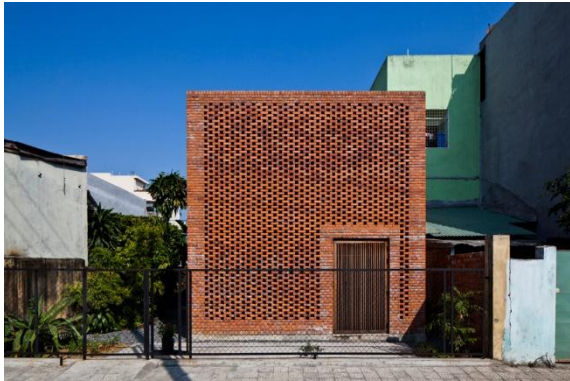
20. kép Téglaburkolat 3. (forrás: Oki Hiroyuki)
