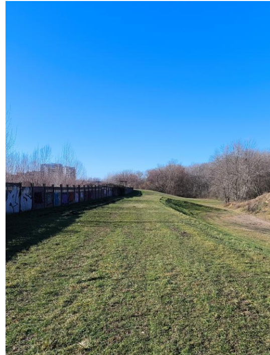
14. fotó - A4 szakasz és környezete a mellette húzódó betonkerítéssel. Ez a szakasz I. rendű védvonalként kijelölt védekezési nyomvonal.
