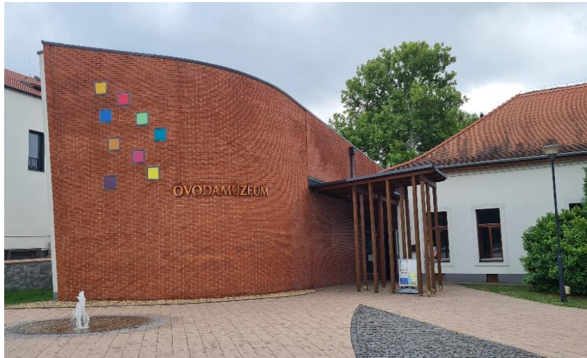
5. ábra: Az Óvodamúzeum 2014-ben átadott új épülete (Forrás: Jné Galló O.)
