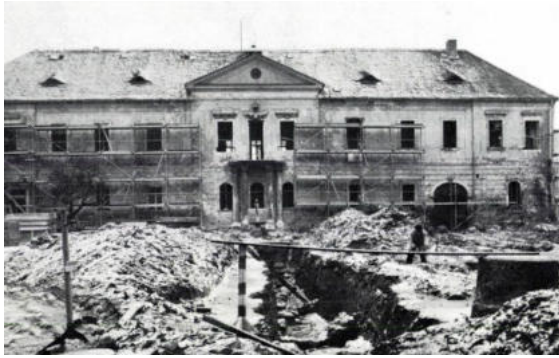
A kastély homlokzatának helyreállítása közben (Magyar Építőipar 1987)
