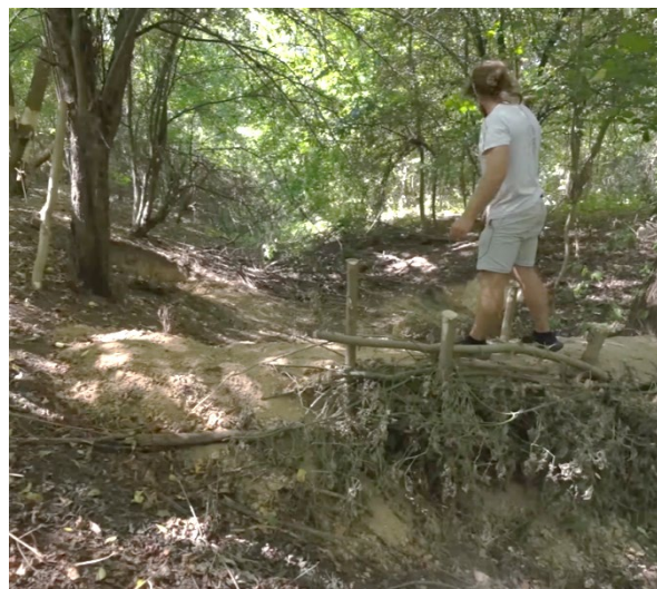
12.ábra: Hosszúcemői tőzeglápon kialakított rönkgát
