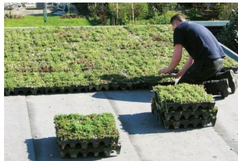
62. ábra: Moduláris zöldtető telepítése
