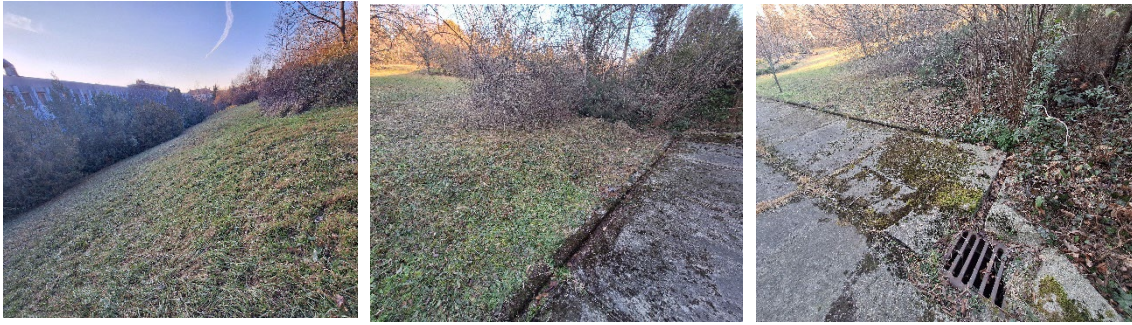
33. ábra: Dombtövi vágás vízvezetés
