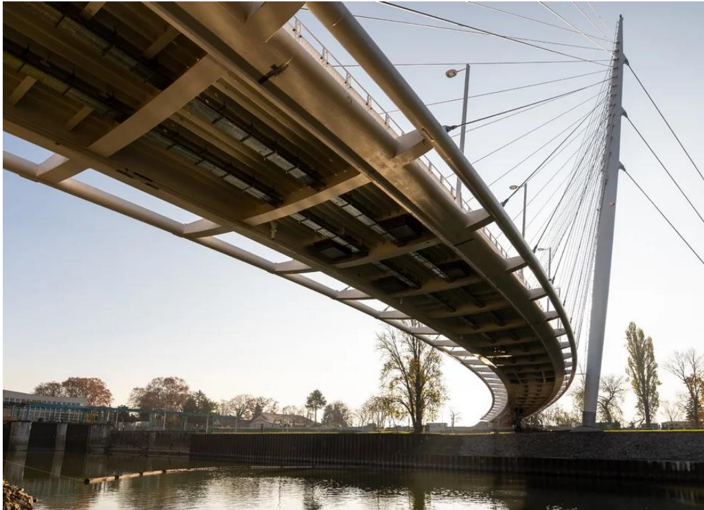
42. ábra: A Csepel-szigetre vezető Robinson híd (forrás: Magyar Építők Zrt.)
