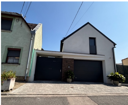
13. Melléklet: Családiház (Forrás: Saját kép)
