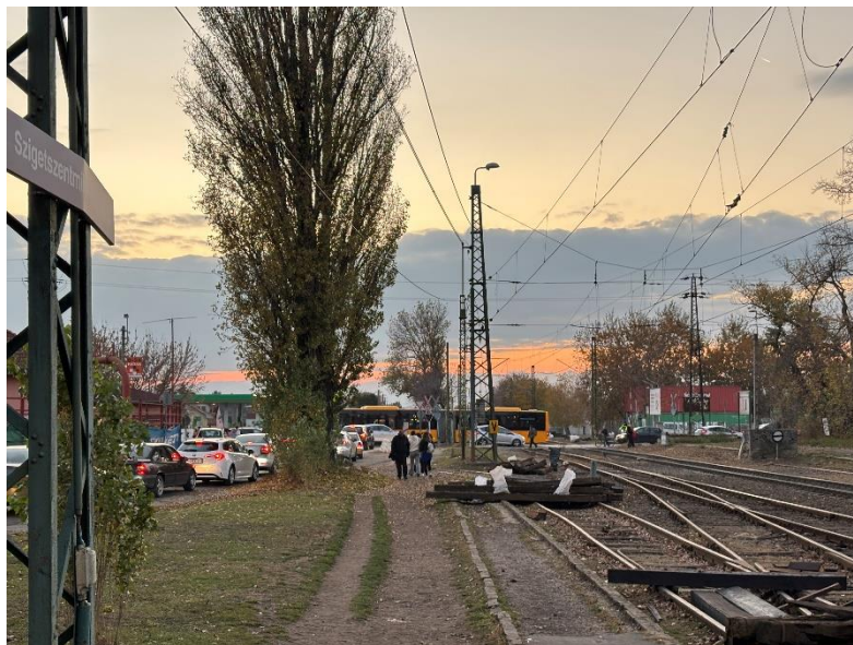
39. ábra Szigetszentmiklós-Gyártelep hévátjáró (forrás: saját kép)
