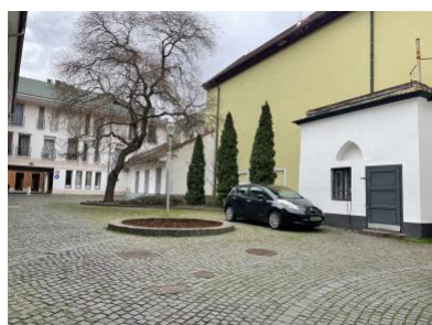
13. melléklet Hanák udvar (saját kép)
