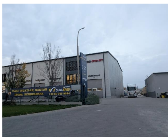
12. melléklet Kereskedelmi, szolgáltató (Forrás: Saját kép, 2025.)
