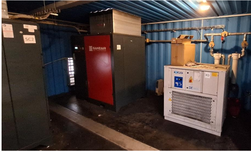
19. ábra: A két kompresszor (balra) és a hűtve szárító egység (jobbra)
