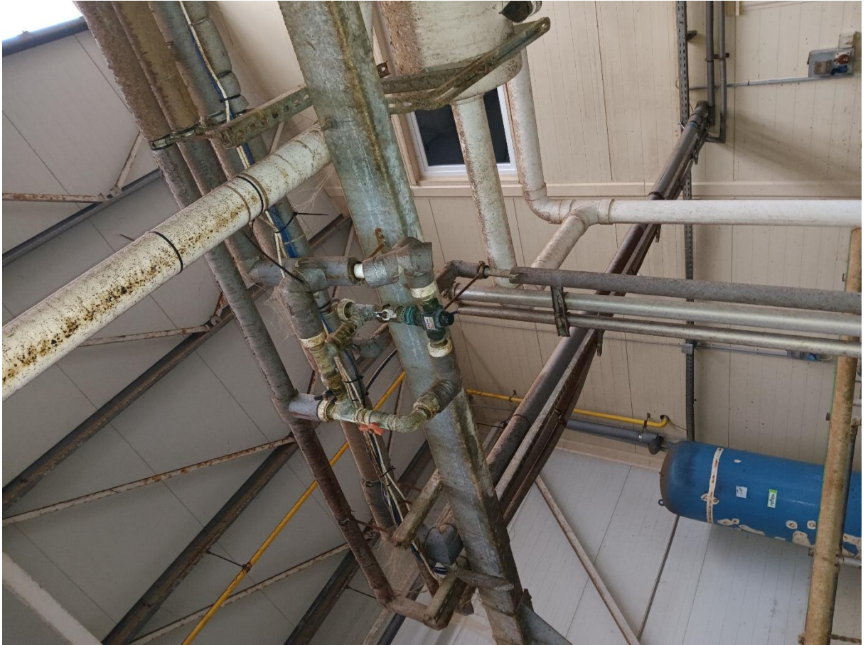
16. ábra Fejőállások 5 keverőszelep
