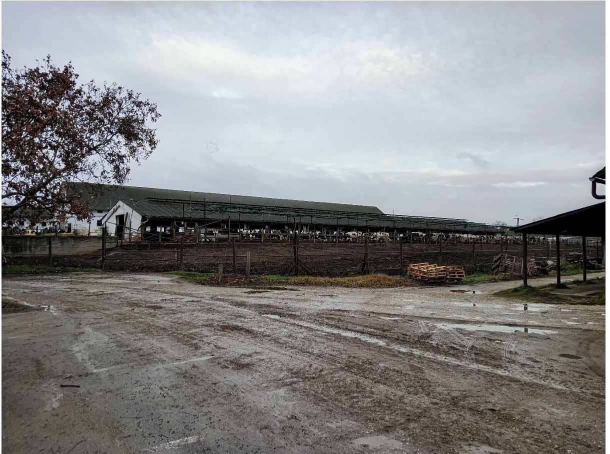
40. ábra Istálló, itt semmilyen melegvíz felhasználás nincsen, csak hideg vízzel és kismarkolóval takarítják
