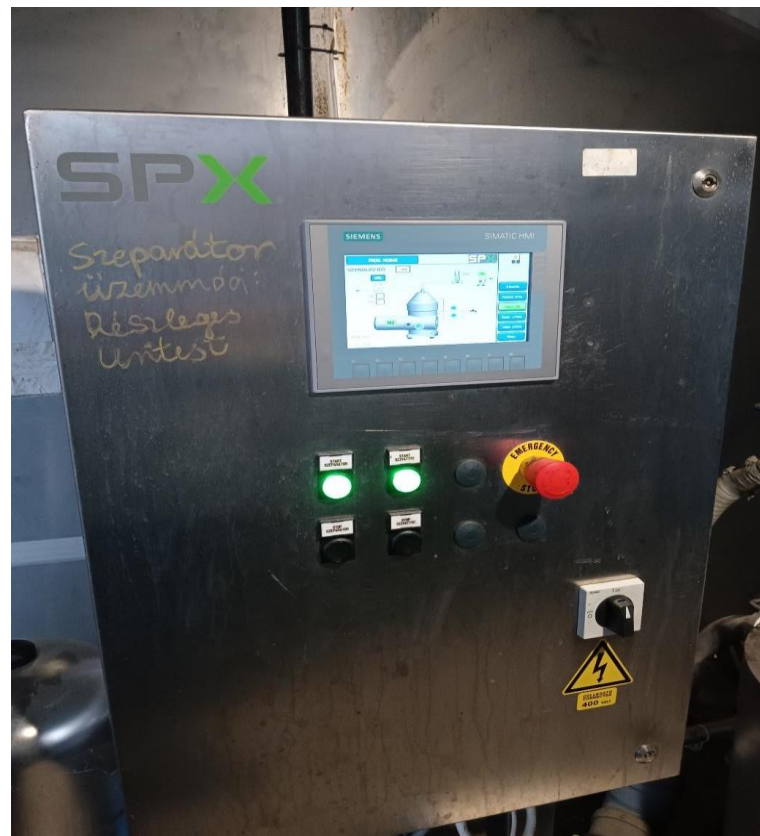
88. ábra Tejhűtő vezérlő panel
