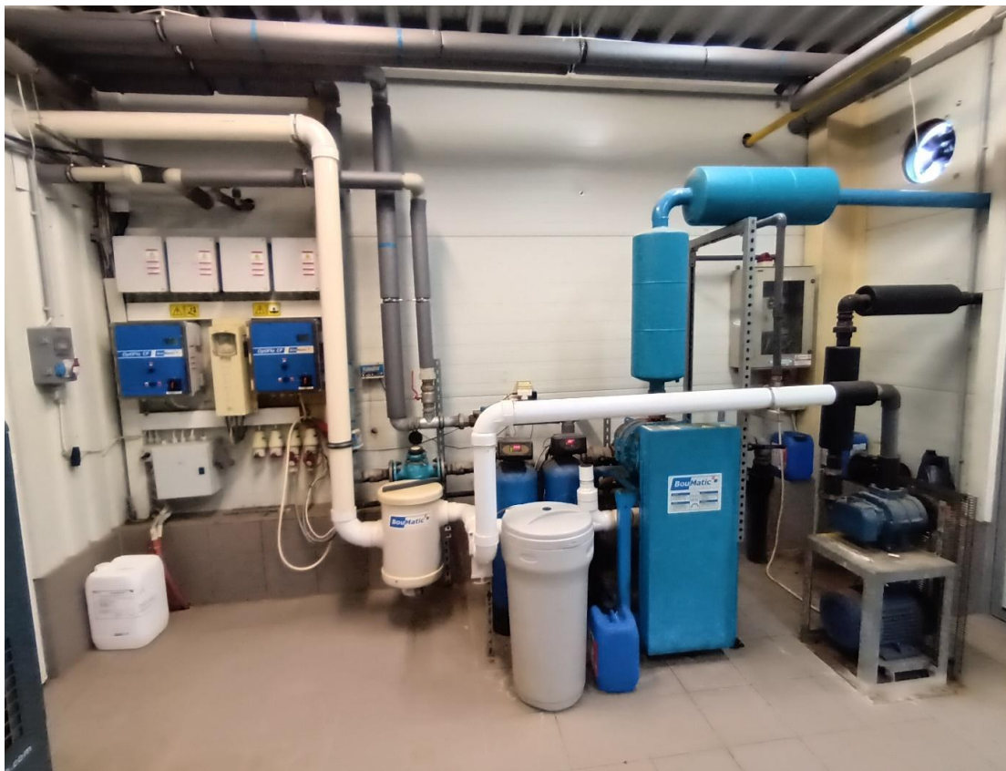
90. ábra Vízlágyító gépészet
