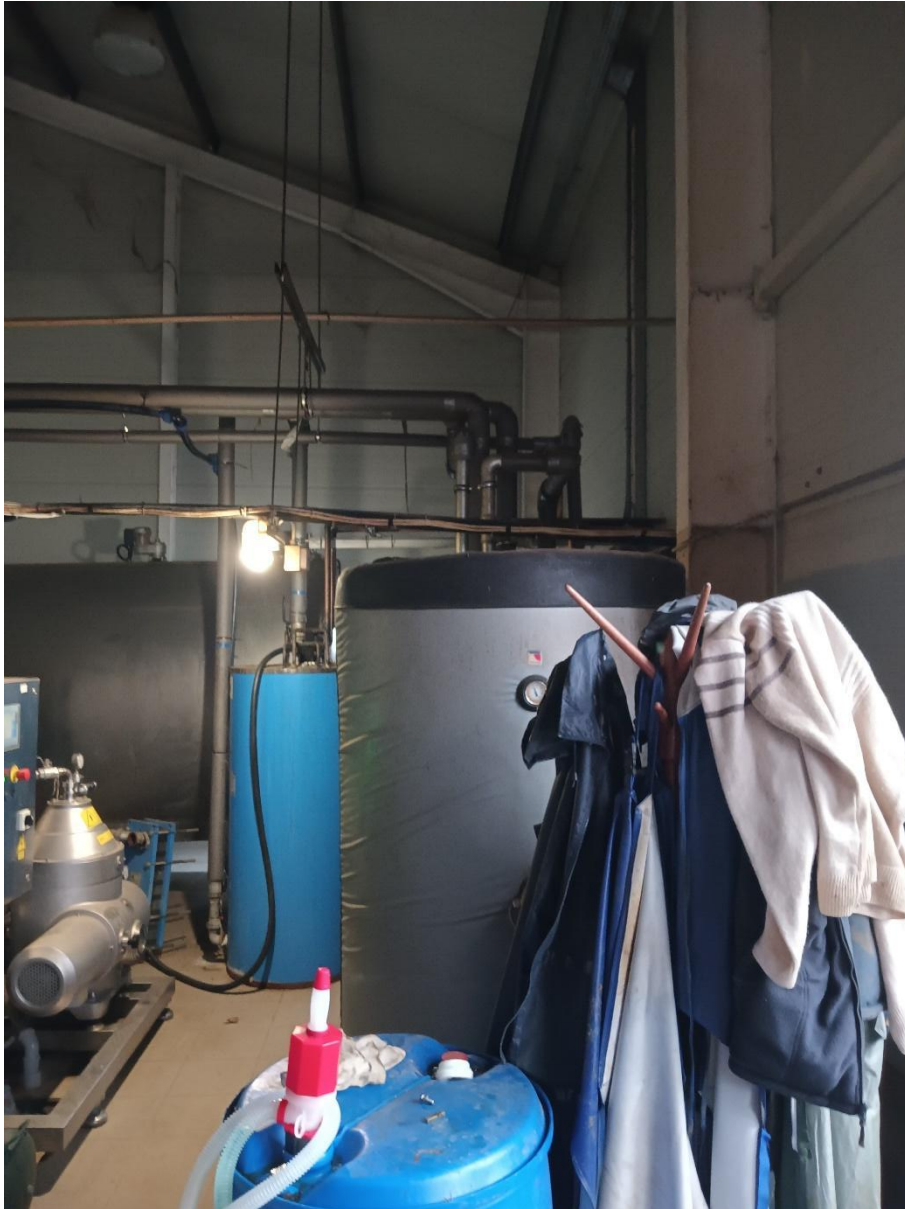
35. ábra Kémiai tisztításhoz szükséges melegvíz termelő gépészet 1
