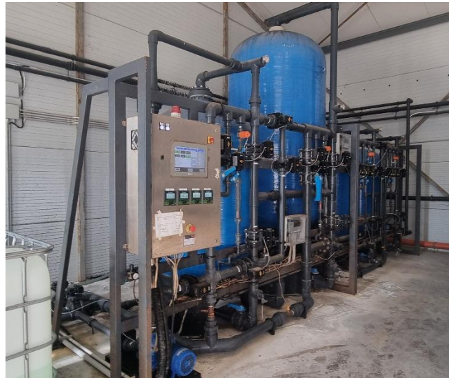
6. ábra: Must finomító berendezés
