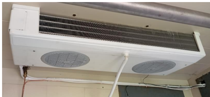
20. ábra – A hűtőtérben található elpárolgató (Saját forrás)
