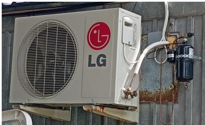
18. ábra - A hűtőkamra kültéri egysége (Saját forrás)
