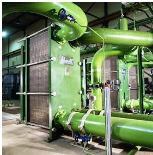
5. ábra: Cső a csőben hőcserélő (Internet 3.) 6. ábra: Lemezes hőcserélő (Internet 4.)
