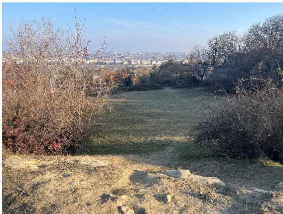
9. melléklet Erodálódott rézsű felső teraszról Saját fénykép
