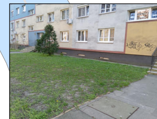
Etele út 18. (Forrás: Saját fotó)
