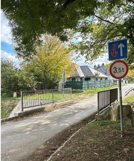
41. ábra: Csap utca - Kálvária utca csomópontjában levő híd (Saját fénykép, Zsámbék, 2025.10.15.)
