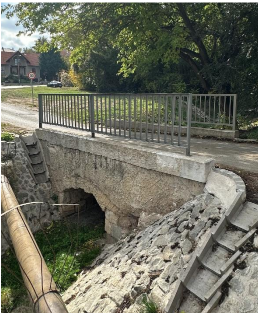
43. ábra: Csap utca - Kálvária utca csomópontjában levő híd (Saját fénykép, Zsámbék, 2025.10.15.)
