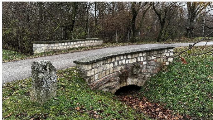
6. ábra: Híd Budajenő határánál (Saját fénykép, 2024.12.10.)
