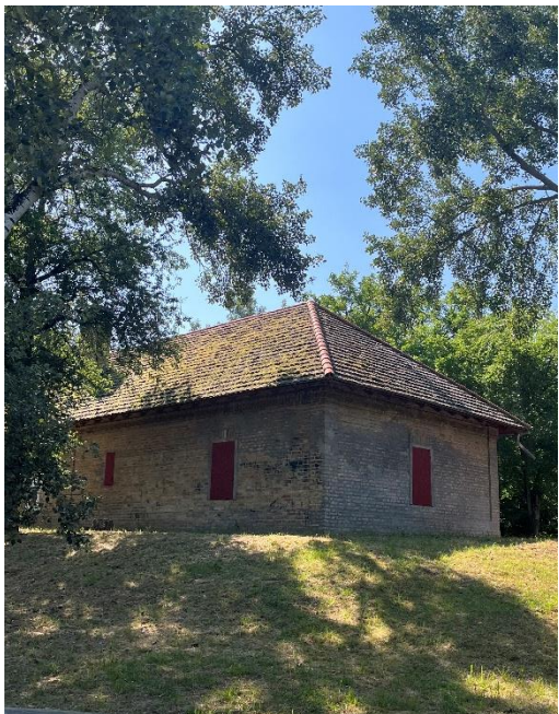
36. ábra: Révház kívülről (forrás: saját fénykép, 2025. 06. 05.)
