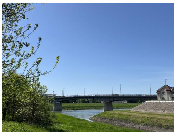
22. ábra: Tisza híd
