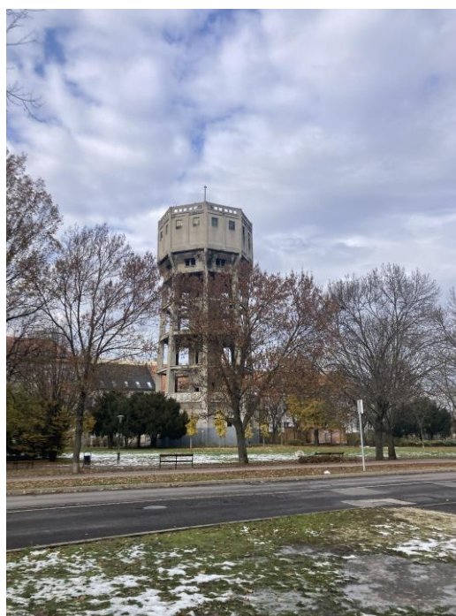
13. ábra: Eötvös téri víztorony
