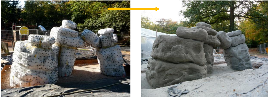
42. ábra: boulder fal kivitelezése forrás: sheffieldboulder
