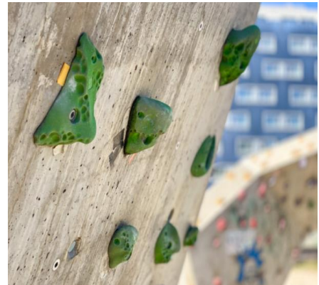
38. ábra: boulder fal anyaga és a fogások forrás: ÖTK
