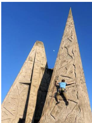
31. ábra: a fal repedései forrás: Mountain Project
