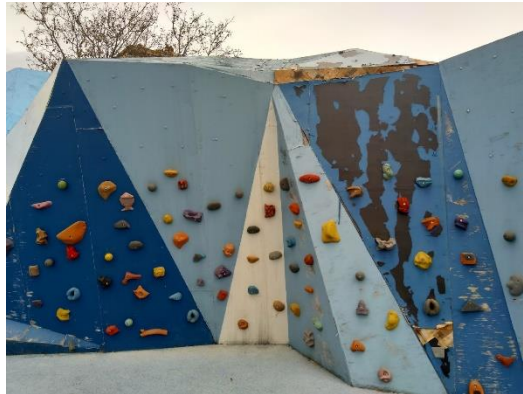
28. ábra: szombathelyi mászófal leamortizálódása forrás: saját kép
