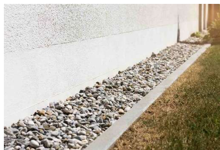
15. ábra Drénárok épület mellett (Forrás: http11 )
