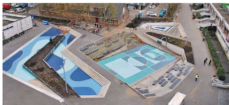
19. ábra Süllyesztett kosárlabdapálya, ami záportározóként működik (Forrás: http14)
