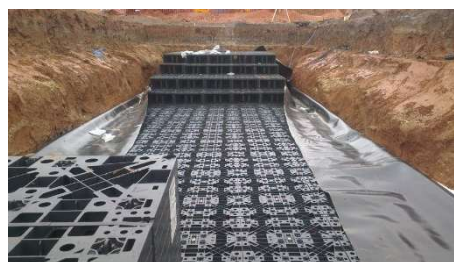
17. ábra Szikkasztóblokkok telepítése (Forrás: http12 )
