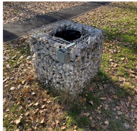
Felújítás utáni gabionfalú kuka
