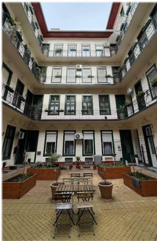
34. ábra: Tavaszmező u. 2. belső homlokzata (Forrás: saját kép, 2025)
