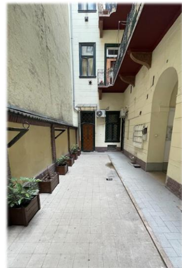
22. ábra: Mátyás tér 17. belső udvara (Forrás: saját kép, 2025)
