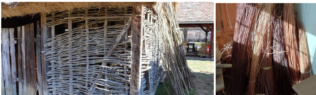
1-2. kép, Vízszintes sövényfonatból készült fal gazdasági épületen; Különböző növényi szár és vessző alapanyag Forrás: Dr. Sárospataki Máté 2023. március 13. Szennai Skanzen; saját kép 2025. május 10. bécsi Schlosshof-i kert
