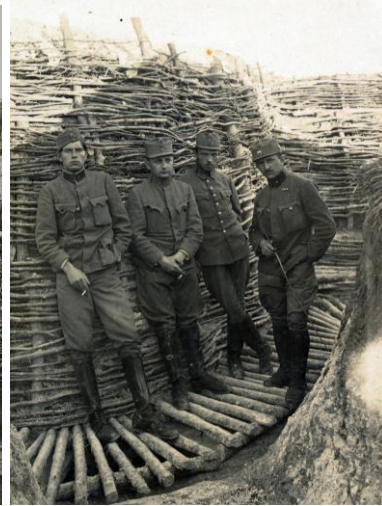
59-60. melléklet kép, Vesszőfalas lövészárók, 1917; Vesszőfallal támasztott lövészárók, 1917 Forrás: Fortepan / Österreichische Nationalbibliothek Képszám: 212698 2025. június 14.; Fortepan / Papp Éva Képszám: 229244 2025. június 14.
