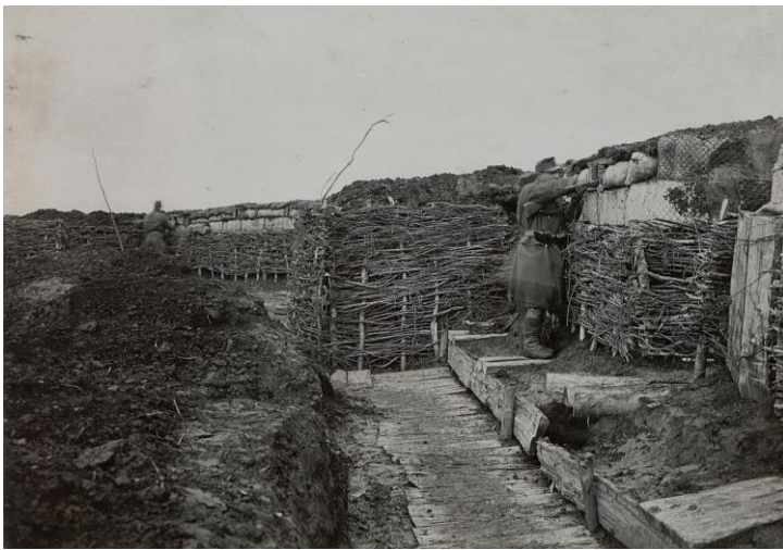
59-60. melléklet kép, Vesszőfalas lövészárók, 1917; Vesszőfallal támasztott lövészárók, 1917 Forrás: Fortepan / Österreichische Nationalbibliothek Képszám: 212698 2025. június 14.; Fortepan / Papp Éva Képszám: 229244 2025. június 14.
