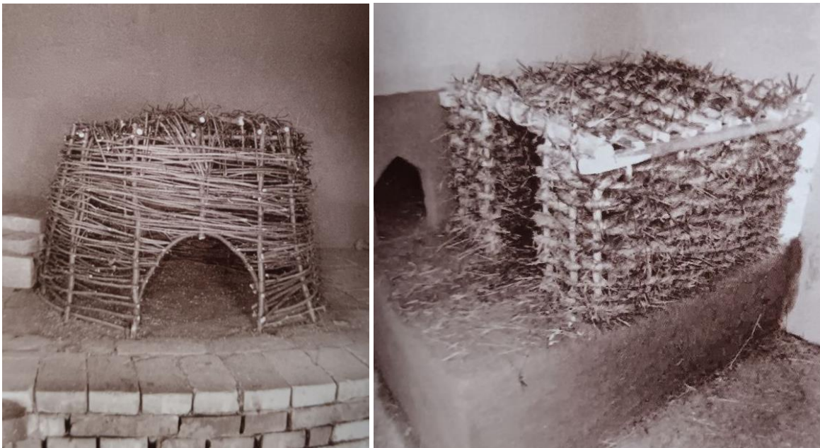
35-36. kép, Vesszőkemence váza, (Szentendre-Csököly, 2005); A karóváz befonása szalmakötelekkel (Szentendre-Szengyörgyvölgy, 1979)
