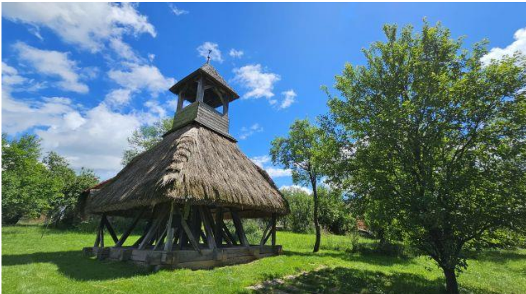
7. kép, Szoknyás harangláb zsúpfedéssel Pankasz legmagasabb pontján
