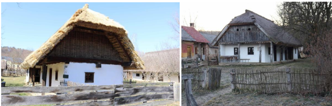
86-87. kép, Zsúp fedéses, fonott oromzatos ház bökdösött belső és deszkázott külső kerítéssel; Zsúp fedéses ház bökdösött kerítéssel
