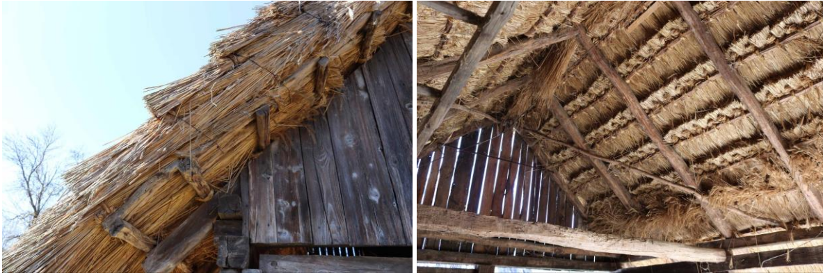
5-6. kép, Hagyományos lépcsőzetes zsúpfedés; Zsúpfedés épület belső szerkezete, lécezése Forrás: Dr. Sárospataki Máté 2023. március 13. Szennai Skanzen; Dr. Sárospataki Máté 2023. március 13. Szennai Skanzen
