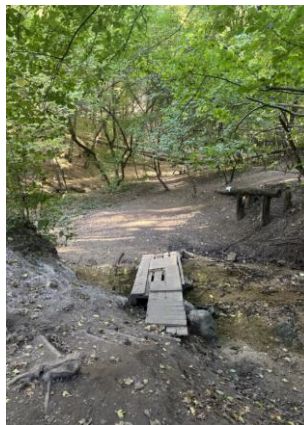
28. kép A Jegenye- völgy hidjának rossz állapota (Forrás: saját kép)
