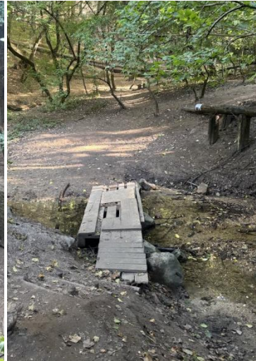
17.Melléklet: Paprikás-patak fölött átvezető hid állapotja (saját kép)
