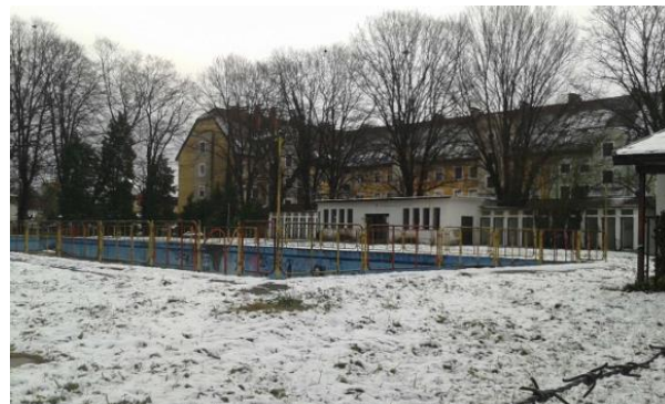
II/28. Melléklet: Volt strandfürdő épületei 2017-ben Forrás: Szentgotthárdi Közös Önkormányzati Hivatal – Karácsony kertterv 2017.
