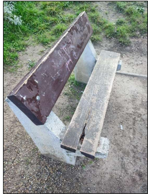
17. ábra: Az ülőalkalmatosság fa ülőfelületének felülről való lefogásánál korhad a fa (Forrás: Saját fénykép, 2024)
