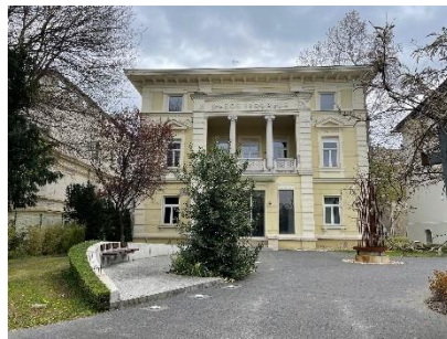
17.kép: Fasor Irodaház, saját fotó, 2025.
