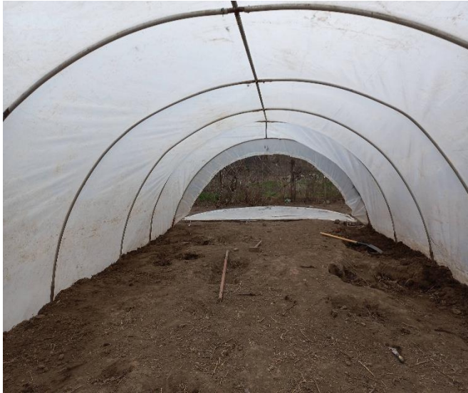
11. ábra. Fóliasátor építése
